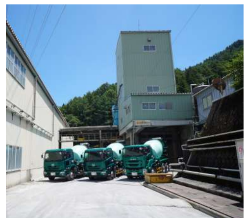
都留工場 能力 120 m 3 /H
