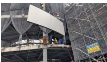
外壁カーテンウォール、手摺PCa
