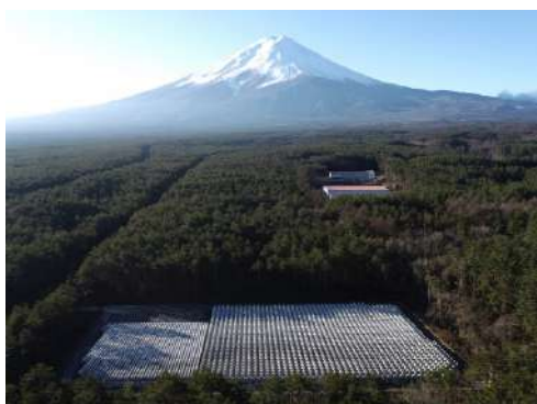
富士山北麓砂防施設整備工事
