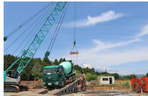
新東名 杭工事
