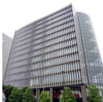
日本体育協会・日本オリンピック委員会新会館 バルコニー板
