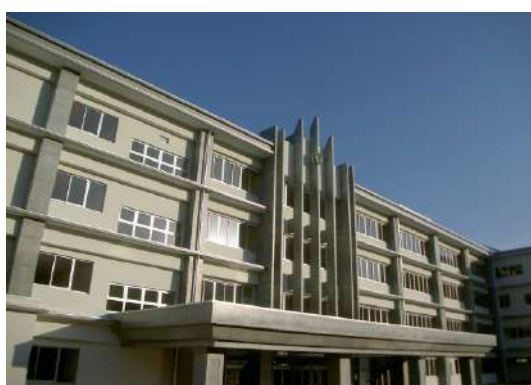
都留興譲館高等学校建設工事
