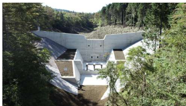
朝沢砂防工事
