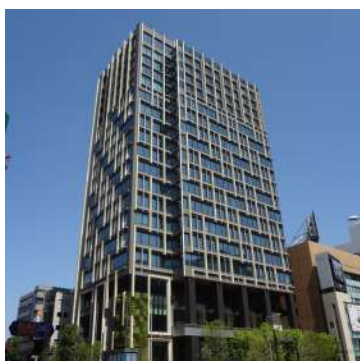
北青山二丁目計画 外壁 PCCW(石打込み 特殊面状)
