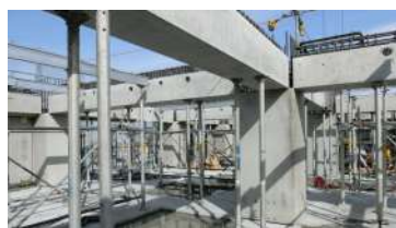
柱、梁、小梁 躯体PCa
