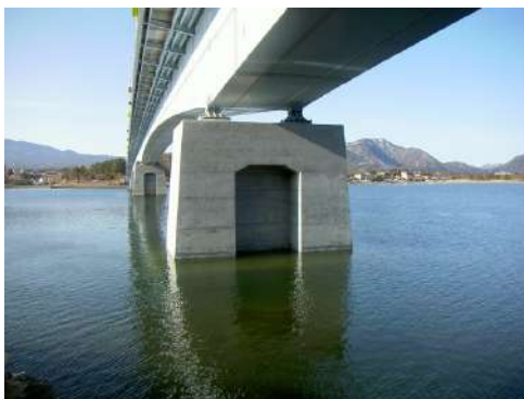
富士河口湖富士線(河口湖大橋)橋梁補修工事
