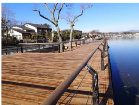
山中湖自転車歩行者道設置その3工事
