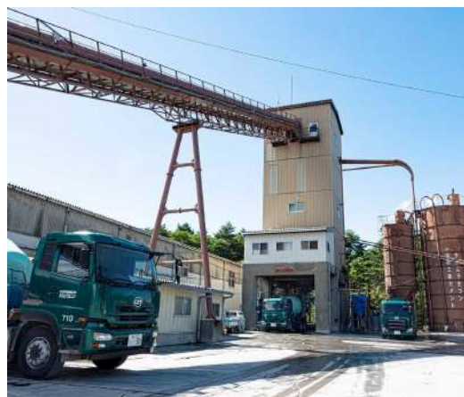
山中工場 能力 240 m 3 /H
