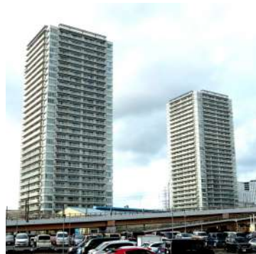
海老名駅間マンション計画 A・B 棟 柱、仕口付き梁
