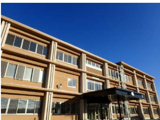
富士吉田警察署庁舎建設工事
